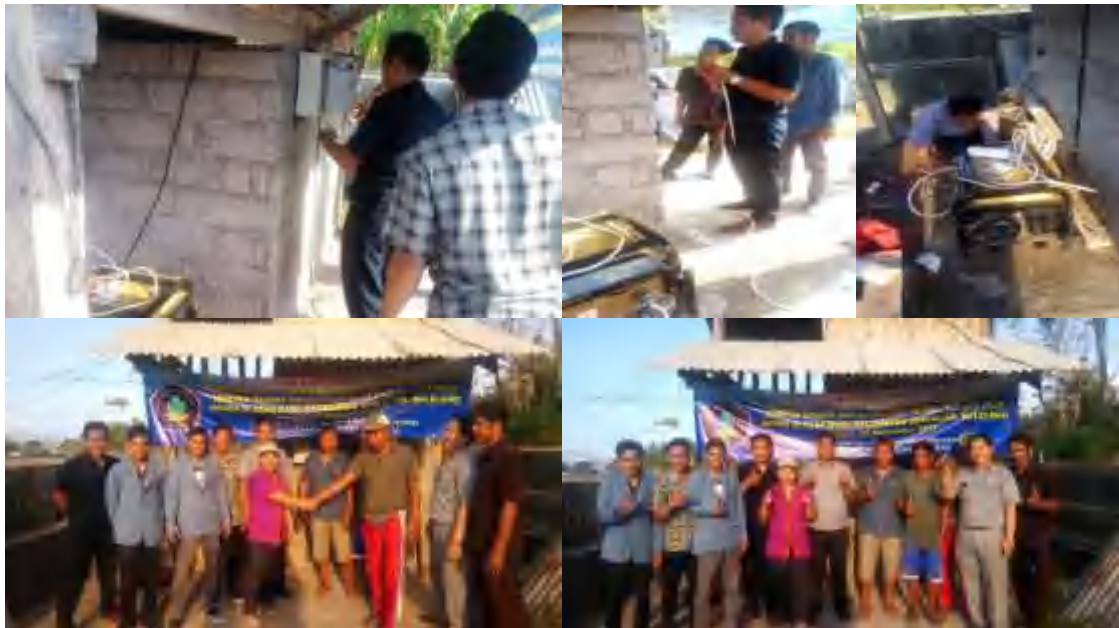
Gambar 7. Pemasangan Panel AMF ATS di Lokasi Kegiatan dan Acara Penutupan
