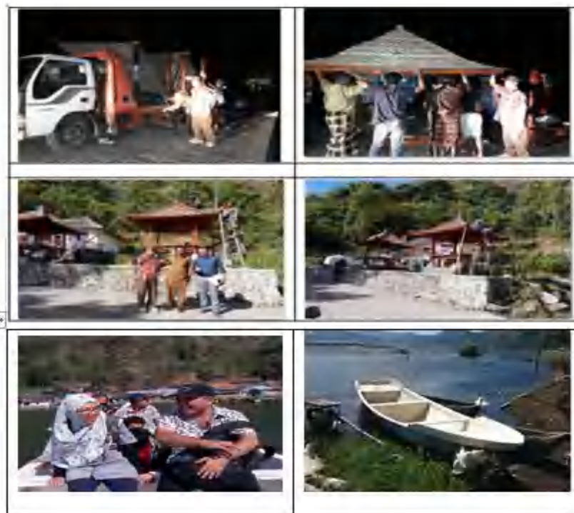
Gambar 4. Instalasi 2 (dua) Unit Gazebo dan 1(satu) Unit Boat Fiber
